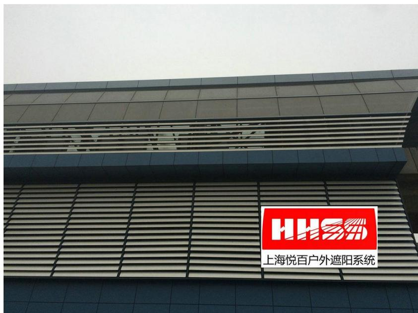
叶片安装方向：横向水平安装或竖向垂直安装，另外一种是在门窗上檐向外悬挑安装，我们也
